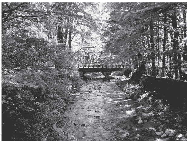
▲矢ヶ崎川に架かる二手橋（北から） *橋左手を少し進んだ場所に莫哀山荘があった。
