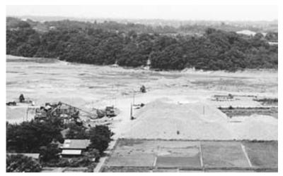
では砂利採取が盛んに行われ、高度経済成長期の京浜地区のビルや道路建設などの骨材として大量に利用されました。しかし、砂利の取り過ぎによる河床低下などの問題を引き起こし、昭和39年3月31日をもって、相模川の砂利採取は全面禁止になりました。この写真が撮影されたのは禁止直後と見られ、川底にはまだ、採取用の機械らしきものが残り、手前(愛川町側)の水田地帯に砂利選別場と砂利山が見えます。
